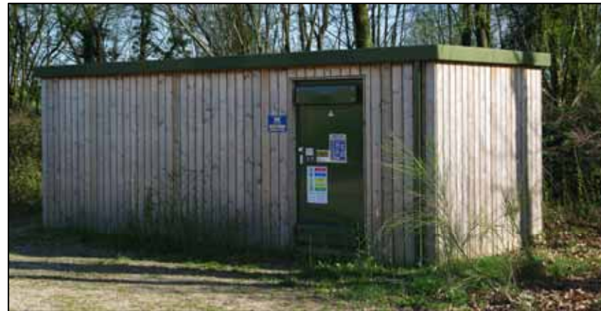
Photographie 14 : Poste de livraison en bardage bois
