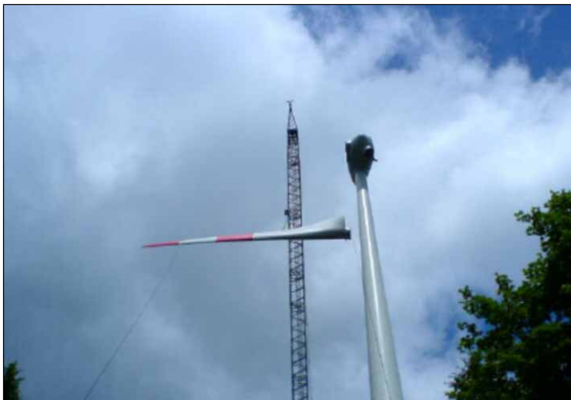
Photographie 13 : Opération de levage d'une pale sur un site éolien en forêt
