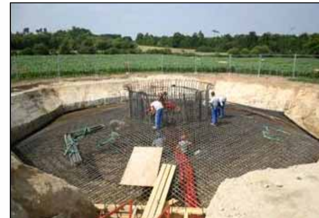
Photographies 11 et 12 : Armature et fondation sur un parc éolien développé par IEL
